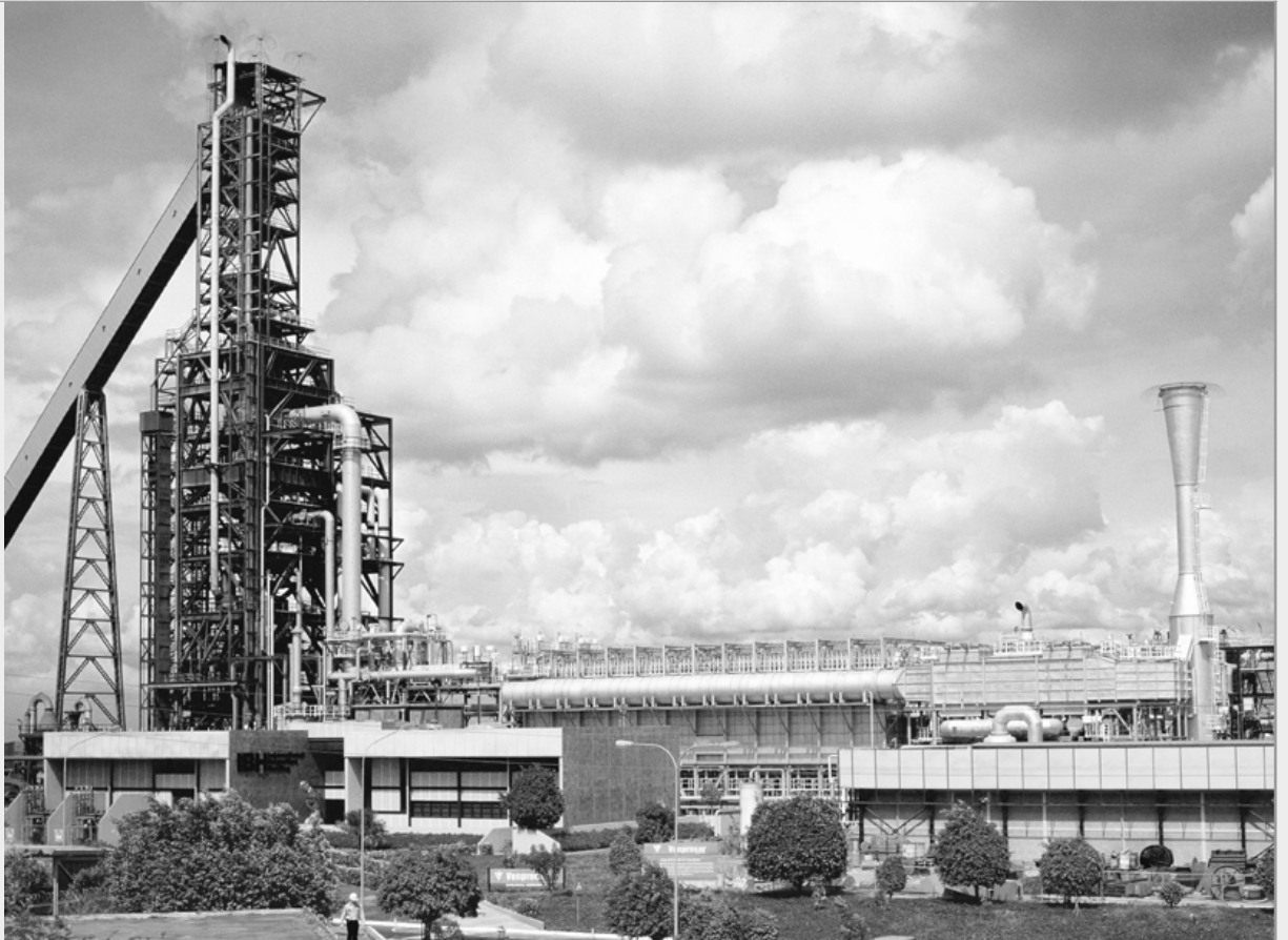
Planta de briquetas Venprecar
